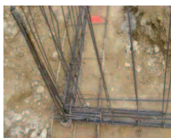
Mise en place d'un chaînage au niveau du rampant d'un bâtiment
